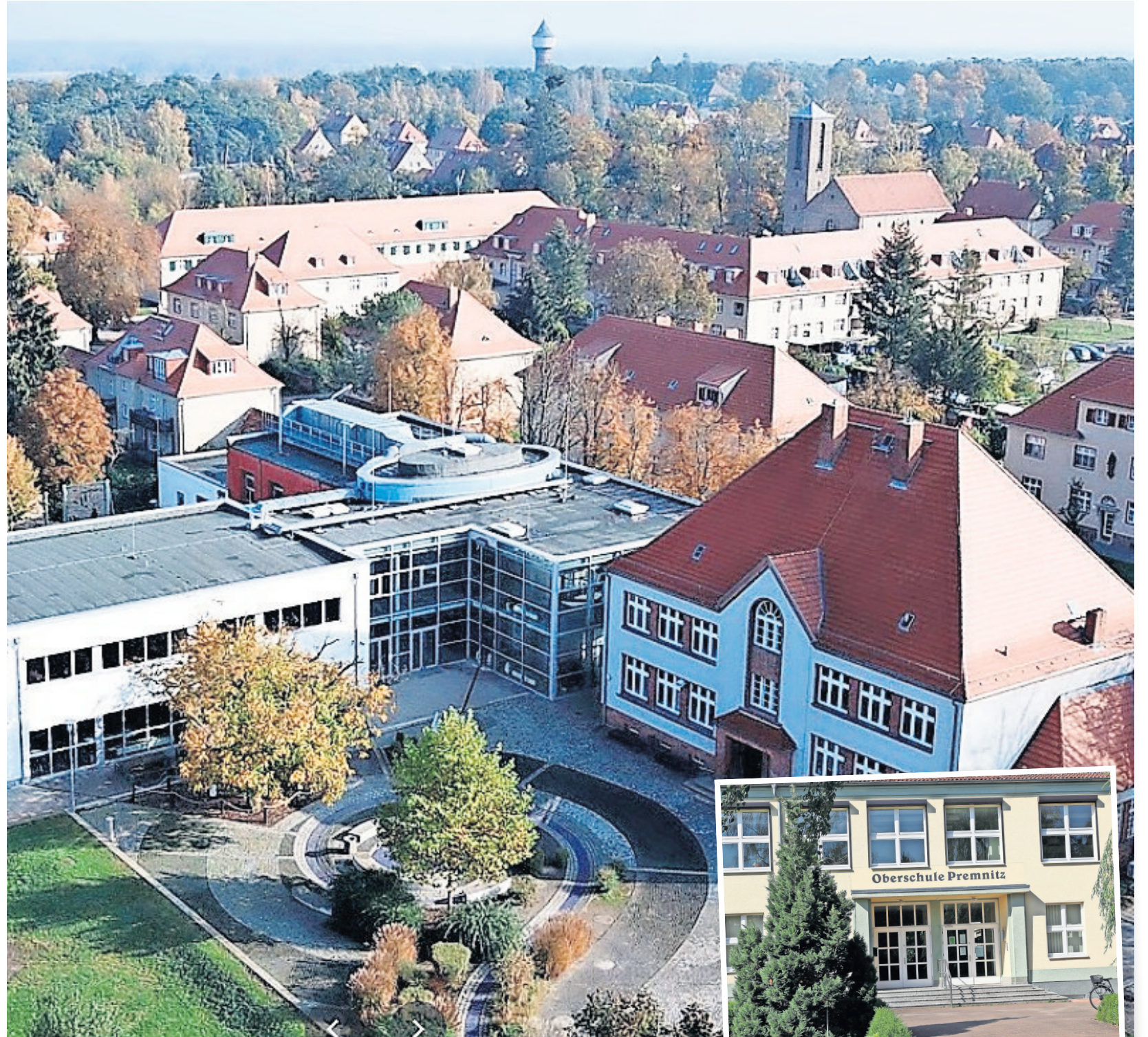
Das Schulzentrum „Heinz Sielmann“ in Elstal wird derzeit um eine Grundschule erweitert. Künftig könnte auch das Abitur in einer Gesamtschule hier möglich sein. So wie in Premnitz (r.) FOTOS: PRIVAT
